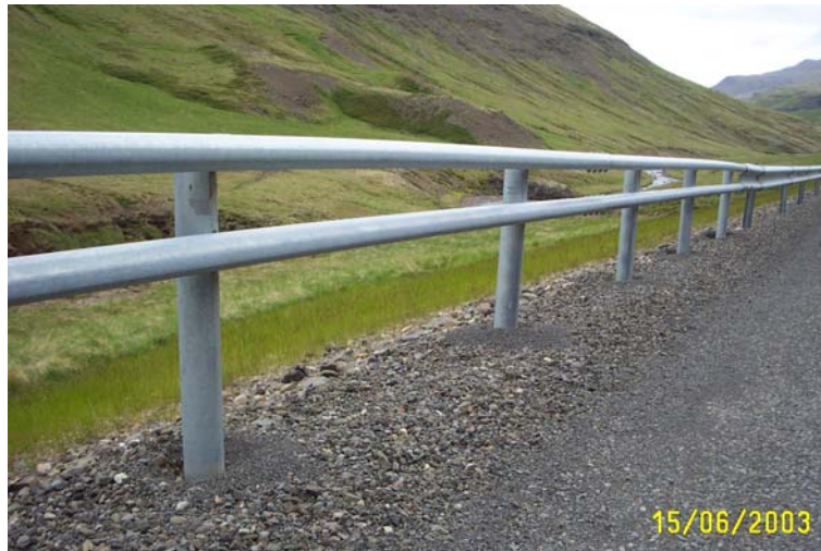
Mynd 1. Röravegrið af Sicuro gerð við nýjan veg á Dalafjalli
