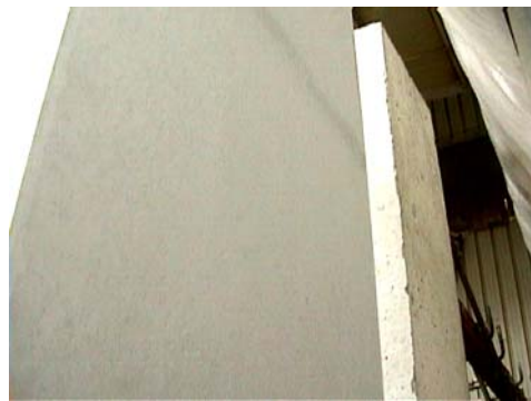
Mynd 2. Tvær súlur, til vinstri er súla úr sjálfútleggjandi steinsteypu en til hægri er hefðbundin steinsteypa.
