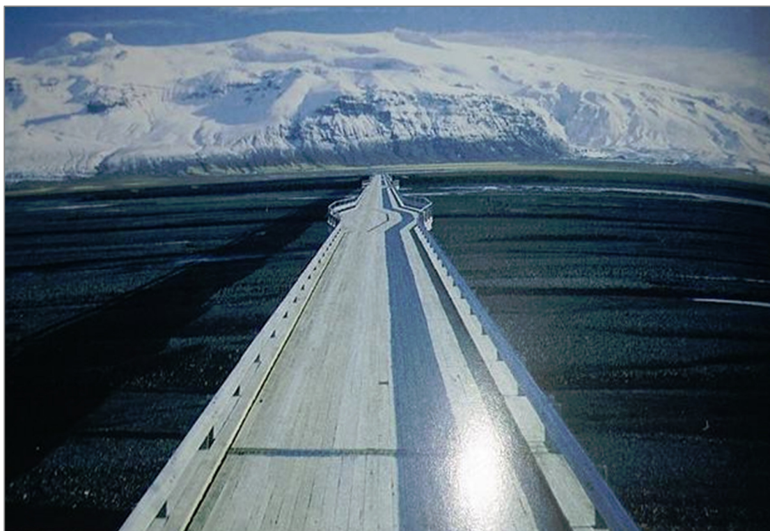
Mynd 4. Núverandi Skeiðarárbú á Skeiðarársandi. Sjá má útskot hennar þar sem bílar eiga að geta mæst. Örfæfaökull er í baksýn (heimild: Íslandshandbókin, 1989).
