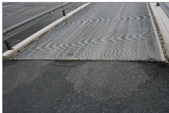
Mynd 7. Stálmottur ofan á timburgólfi núverandi brúar á Skeiðarársandi (úr myndasafni veggagnabanka Vegagerðarinnar).
