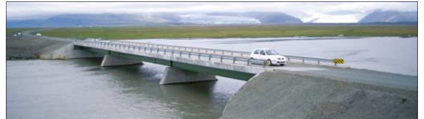
Hringvegur (1), ný brú yfir Hólmsá á Mýrum.
