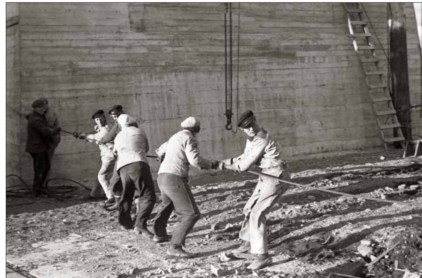
Brúarvinnu menn við Ölfusá 1945. Af öðrum myndum að dæma á þessari filmu eru mennirnir að fást við vír sem síðan hefur verið notaður til að draga burðarkaplana yfir. Það hefur örugglega verið gert með einhverkonar vélarafli því útilokað er að handaflið hafi ráði við það.
