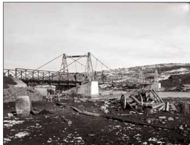
Hengibrúin yfir Sogið var flutt og sett upp á Kjalvegi yfir Hvítá hjá Bláfelli.
