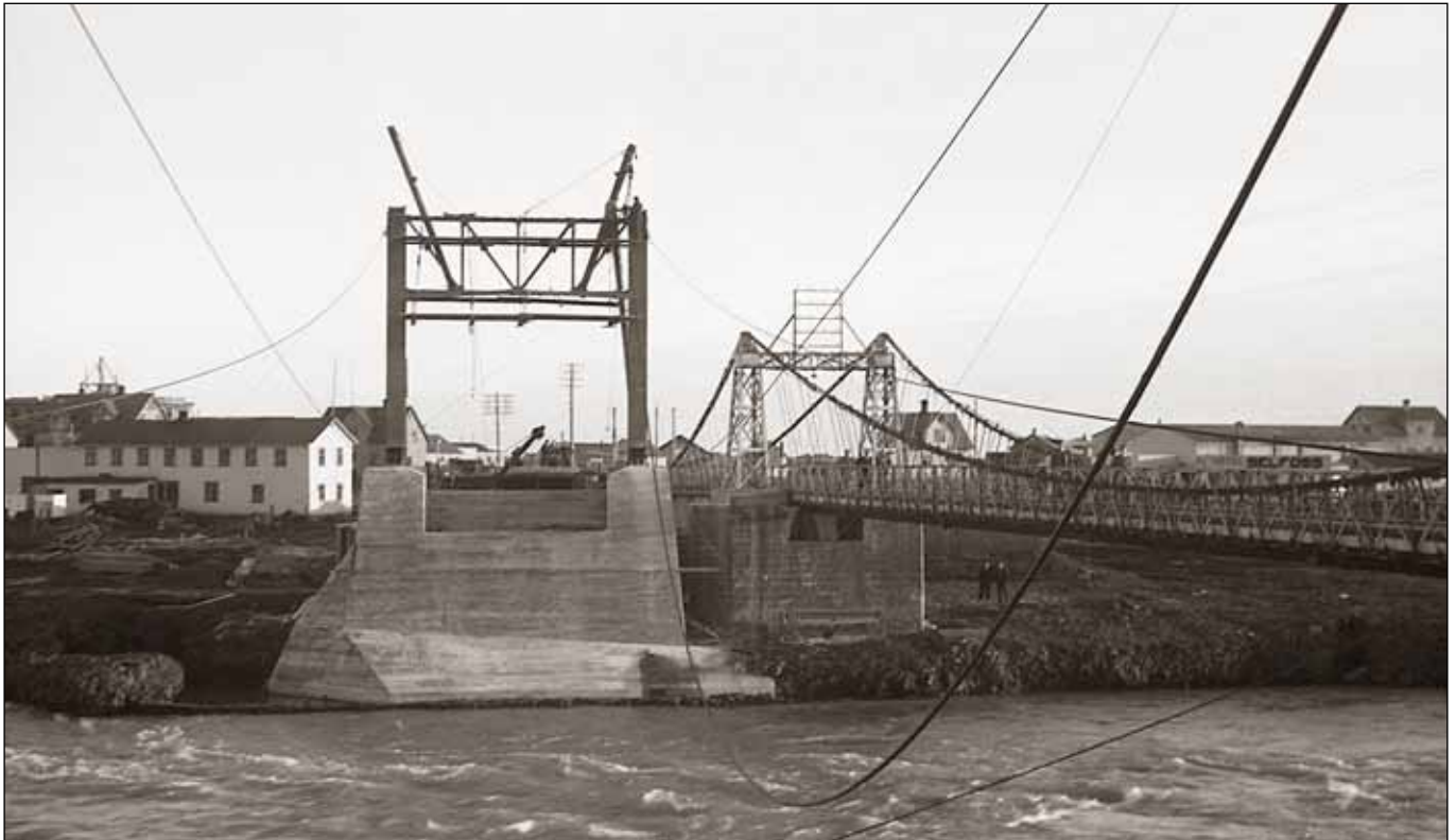
Ný hengibrú yfir Ölfusá í byggingu 1945. Burðarvívar dregnir yfir ána. Gamla hengibrúin til hliðar. Mynd: Geir G. Zoëga.
