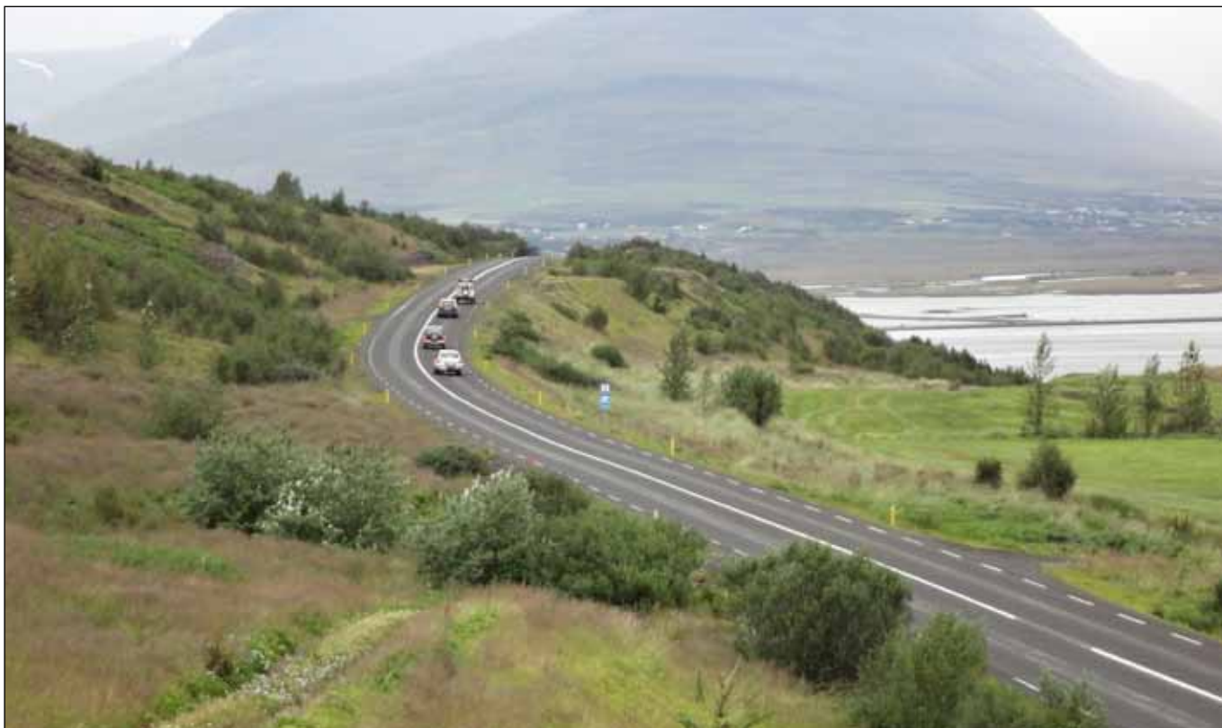
Hringvegur (1) austan Akureyrar. Á þessum stað verður sett upp bráðabirgðabráú yfir veginn vegna framkvæmda við Vaðlaheiðargöng. Mynd: Guðmundur Birkir Guðmundsson.
