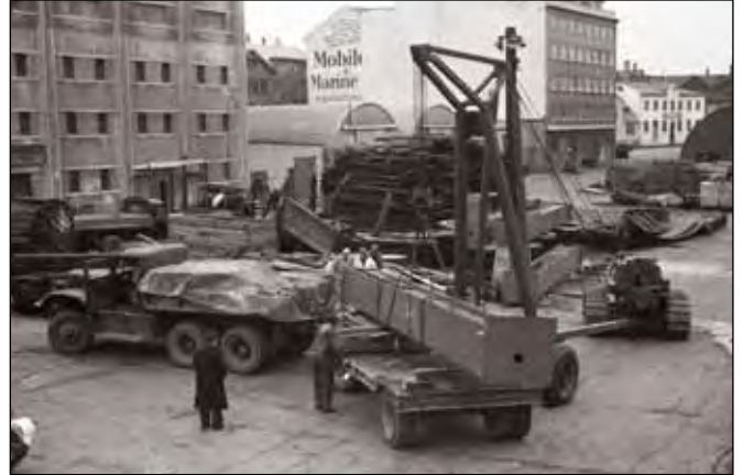
Efni í Ölfusárbrú sett á bíl á hafnarbakkanum í Reykjavík 1945.
