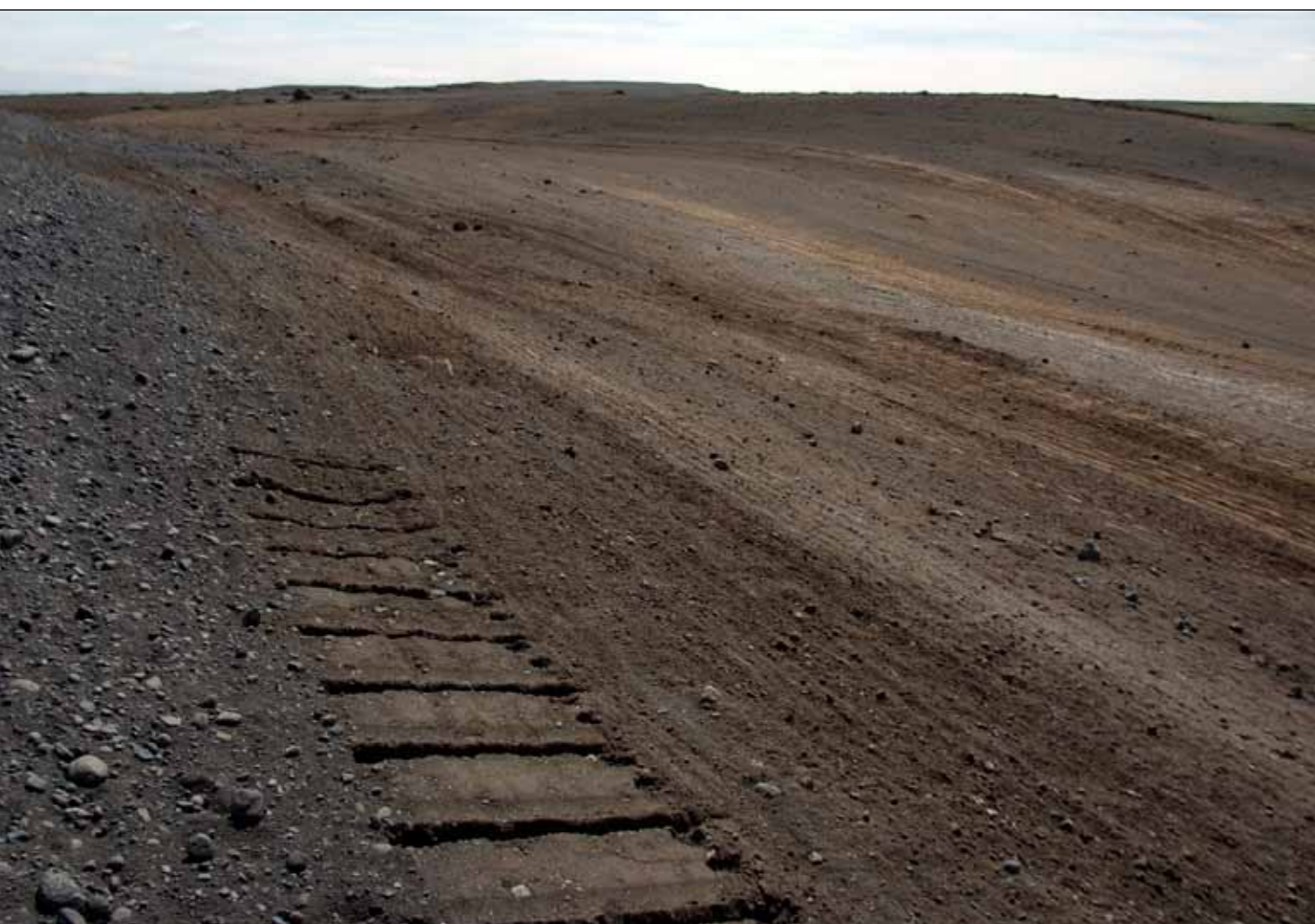
Landmótun eftir framkvæmdir við nýjan Dettifossveg. Keðjumotta sem dregin er á eftir ýtunni jafnar yfir ýtuförin. Sjá frétt á forsíðu.
