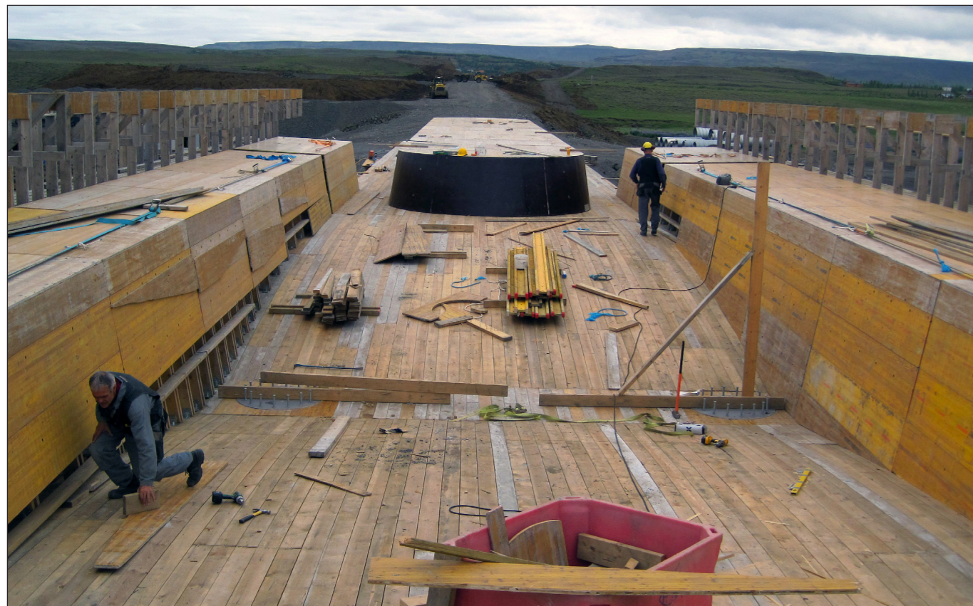
Brúargerð. Hvítá hjá Bræðratungu. Verktaki: Ræktunarsamband Flóa og Skeiða. Undirverktaki: Jáverk ehf. Mynd: Svanur G. Bjarnason 18. júní 2010.
