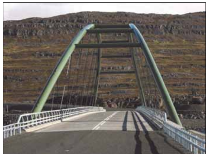
Nýbygging, Djúpvegur (61), brú yfir Mjóafjörð.
