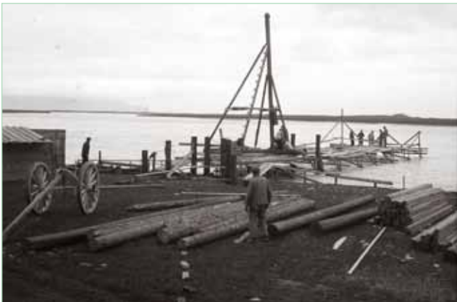
Þverá í Landeyjum. Brúargerð. Verið er að reka niður staura með fallhamri.
