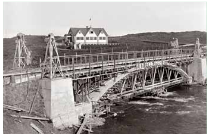
Sogið. Árið 1935 var sett burðarmeiri bogabrá í stað hengibrúar. Verið er að taka hengbrúna niður. Þrastarlundur í baksýn
