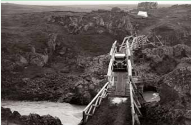
Brú yfir Skjálfandafljóti við Fosshól. Hinum megin við brúna er tjald og hús í byggingu.
