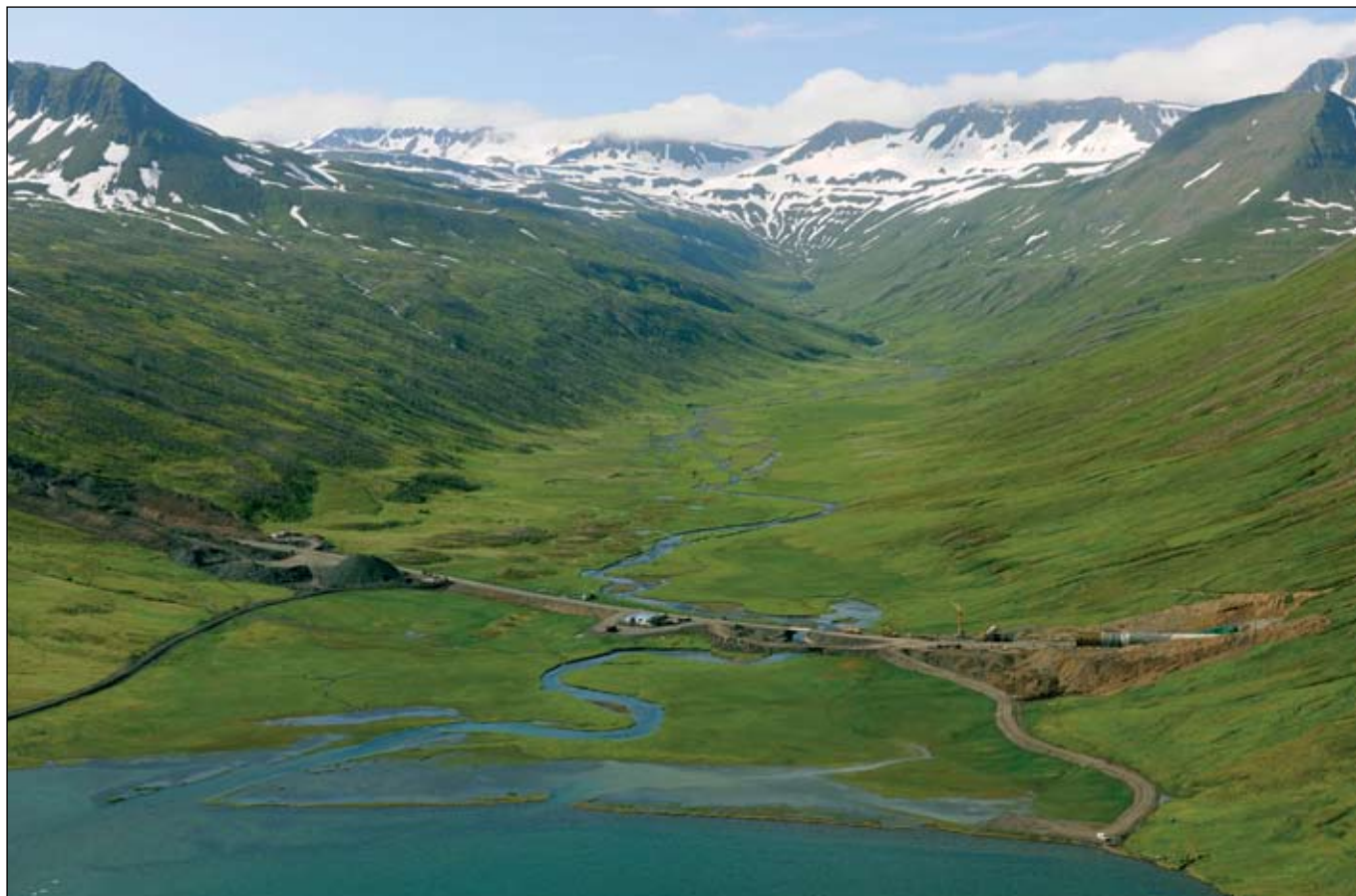
Héðinsfjarðargöng 9. júlí 2009. Vegtenging milli gangamunna í Héðinsfirði. Vegskáli Siglufjarðamegin er langt kominn. Lokið er við að gera endanlegar styrkingar í göngum. Ljósmynd Mats Wibe Lund.
