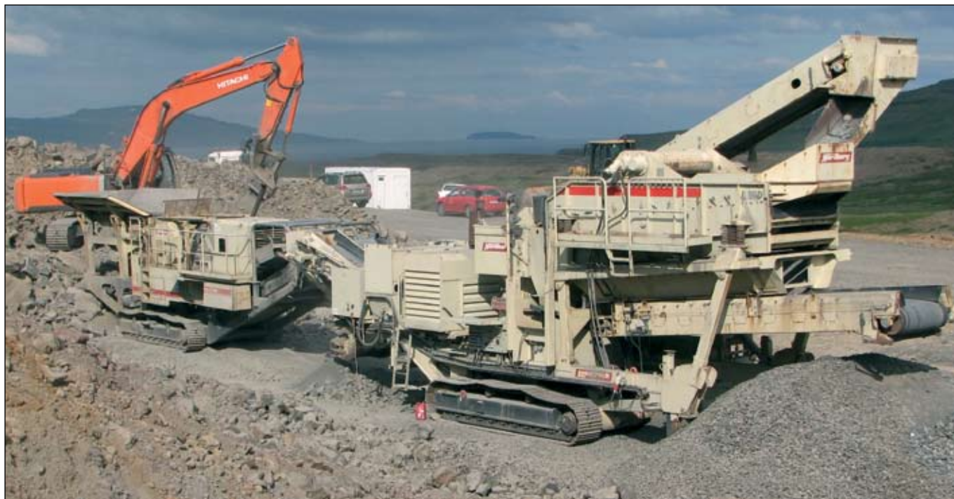
Töllatunguvegur (605), Vestfjarðavegur - Djúpvegur. efnisvinnsla. 1. júlí 2009. Ljósmynd: Hafdís Eygló Jónsdóttir.
