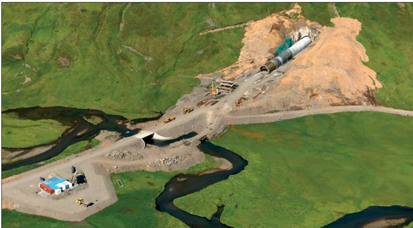
Hédinsfjarðargöng. Unnið við vegskála í Hédinsfirði 9. júlí 2009. Sjá einnig á bls. 3. Ljósmynd Mats Wibe Lund.
