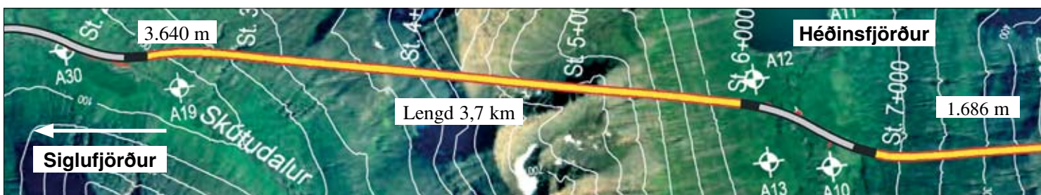
Staða framkvæmda við Héðinsfjarðargöng 15. des. 2008. Sprengingum frá Siglufirði til Héðinsfjarðar lauk 21. mars 2008.
