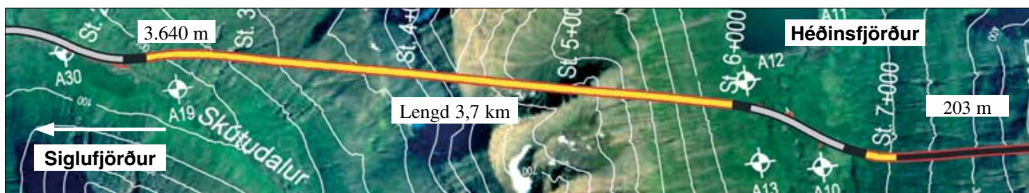
Staða framkvæmda við Héðinsfjarðargöng 2. júní, 2008. Sprengingum frá Siglufirði til Héðinsfjarðar lauk 21. mars 2008.
