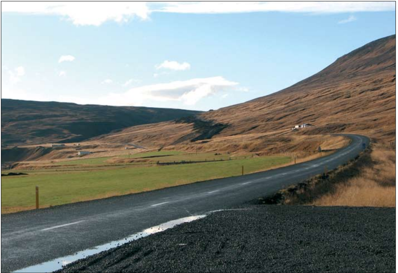
Hringvegur (1) í Jökuldal. Framkvæmdir: Ármótasel - Skjöldólfsstaðir. Sjá einnig mynd bls. 3.
