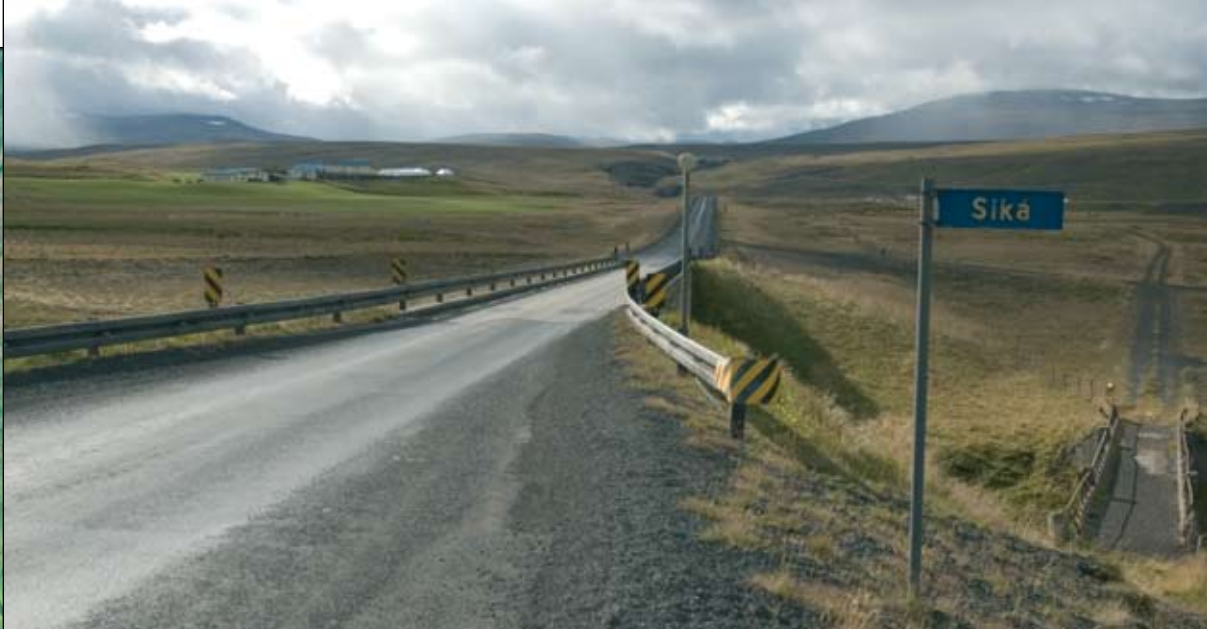
Brúin yfir Síká í Hrótafirði er síðasta einbreiða brúin á Hringvegi (1) milli Reykjavíkur og Akureyrar. Með nýjum vegi og brú yfir Hrótafjarðar á verður leiðin ekki lengur um þessa brú.
