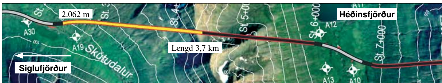
Staða framkvæmda við Héðinsfjarðargöng 23. júlí 2007. Búið er að sprengja 2.062 m í Siglufirði og 1.495 m í Ólafsfirði.
