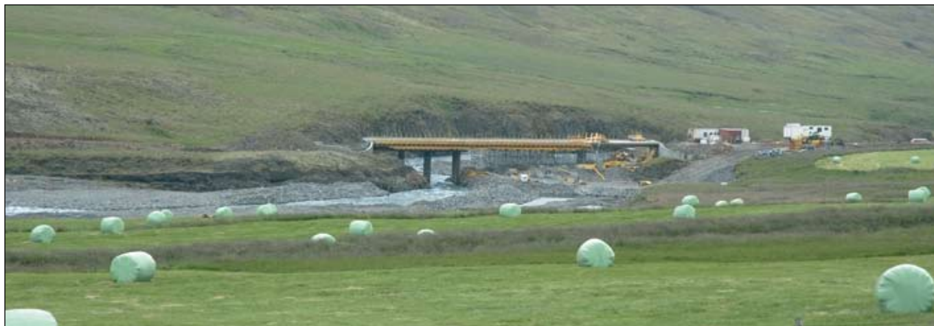
Hringvegur (1), brú á Norðurá í Norðurárdal í Skagafirði. Myndin er tekin 22. júlí sl.
