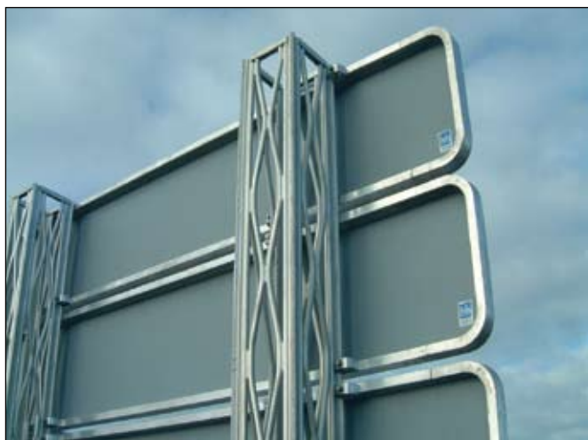
Festing skilta við staur.
