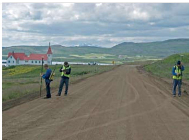
Úttektarmæling við Prestbakka í Hrótafirði. Jón Rafn Oddsson til vinstri og Björn Halldórsson til hægri að mæla yfirborð vegarins, en Gunnar Sigurgeirsson skráir niðurstöður beint í fartölvu.
