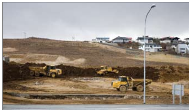
Framkvæmdir við Reykjanesbraut í Garðabæ.
