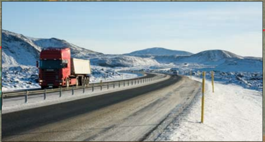
2+1 vegur í Svínahrauni. Víravegrið skilur akstur Stefnum að. Aetlunin er að svona vegur verði alla leið frá Hveragerði til Reykjavíkur.
