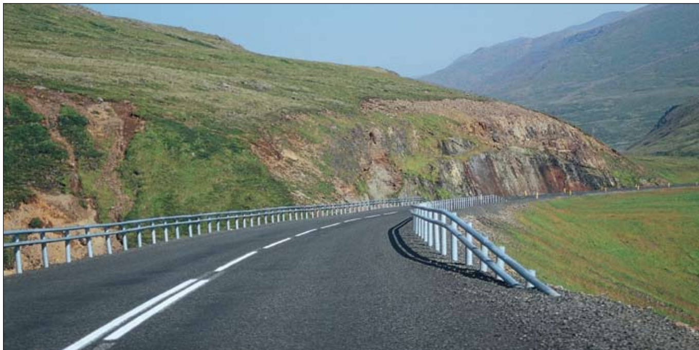
Vestfjarðavegur (60) um Bröttubrekku.
