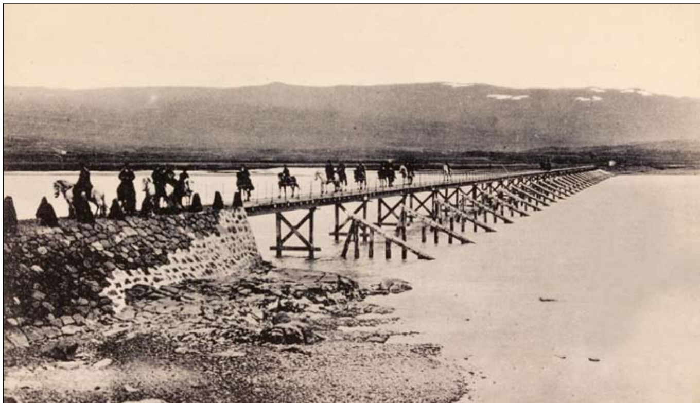
Lagarfljót hjá Einhleypingi (Egilsstöðum): brúin frá 1905; var á stauraokum með stálbitum. Endurbyggð brú á steiptum stöplum með stálbitum og trégólfi var tekin í notkun 1958. Ísbrjóar eru framan við stauraokin. Mynd af póstkorti á Þjóðminjasafni Íslands.
