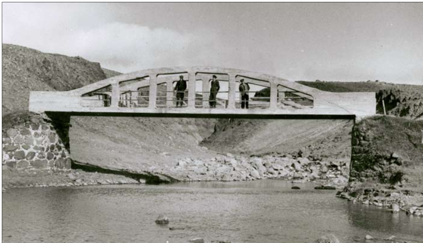
Hvassá í Norðurárdal (hjá Fornahvammi). Brú frá 1911; steipt grind, sem var einstök af þeirri gerð og efni. Brúin var á þjóðleiðinni þar til vegurinn var færður í byrjun 4. áratugar síðustu aldar. Féll undan snjóþunga veturinn 1995.
