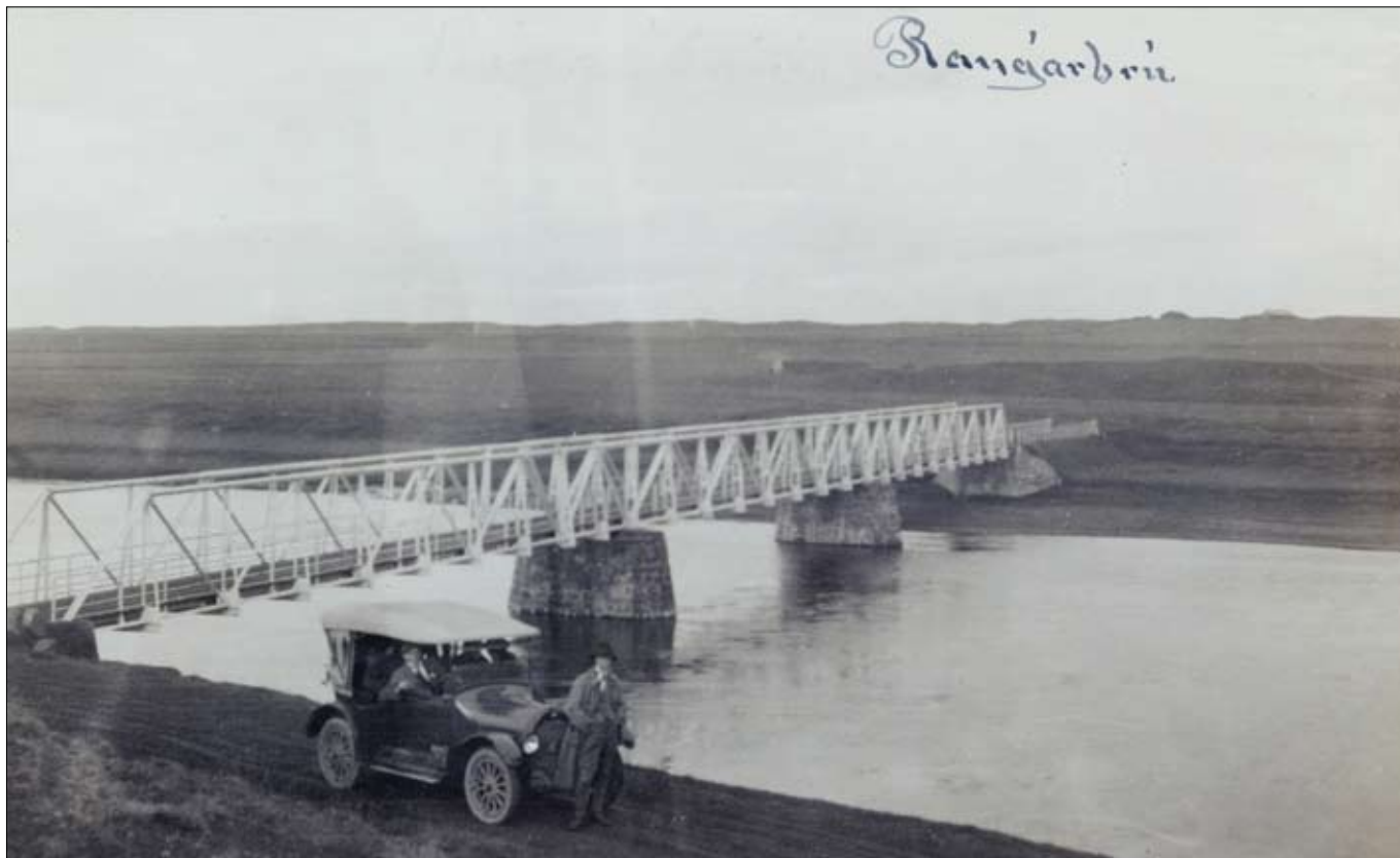
Ytri-Rangá undir Ægissíðuhöfða (Hellu): brúin frá 1912; brúarstæðið er ½ km ofar en núverandi brú, sem er steypt bitabrú og tók við 1960. Mynd á Þjóðminjasafni Íslands.
