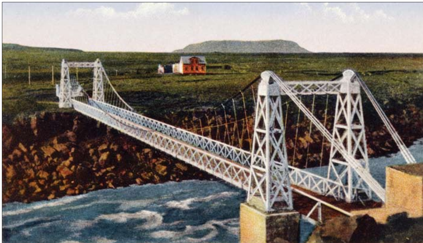
Þjórsá hjá Þjótanda: hengibrúin frá 1895; fyrsta stálbrúin þar sem íslenskur verkfræðingur (Sigurður Thoroddsen) kom við sögu. Stálgrindarbrú leysti hana af hólmi 1949. Mynd af póstkorti.
