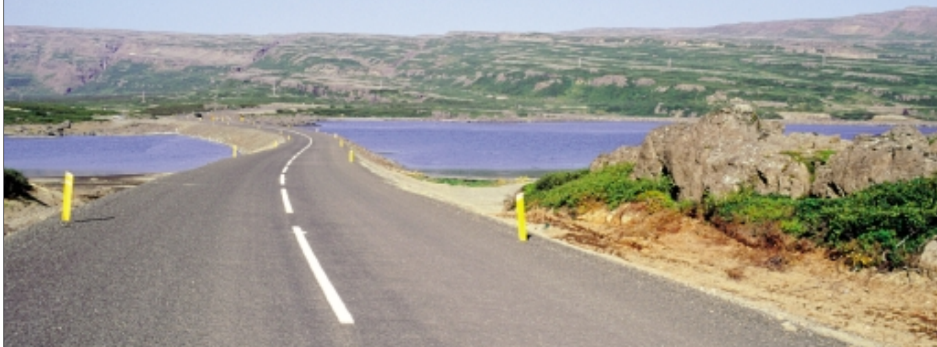
Vestfjarðavegur (60) í Vattarfirði. Þarna var lagt bundið slitlag sumarið 2003.
