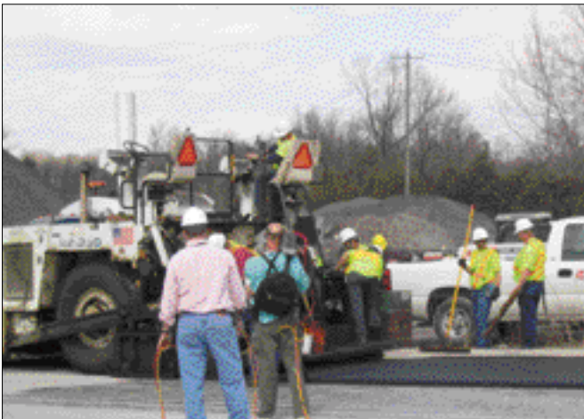
Unnið að útlögn. Takið eftir, enginn reykur!
