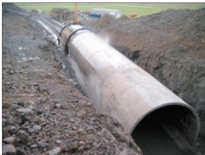
Fáskrúðsfjarðargöng. Vegskáli í Fáskrúðsfirði.
