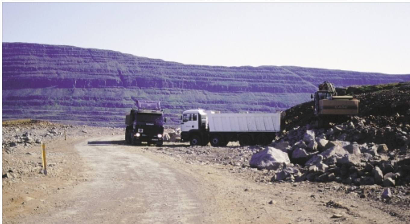
Vegagerð í Hestfirði í Ísafjarðardjúpi 16. ágúst. Verktaki er Klæðning ehf.
