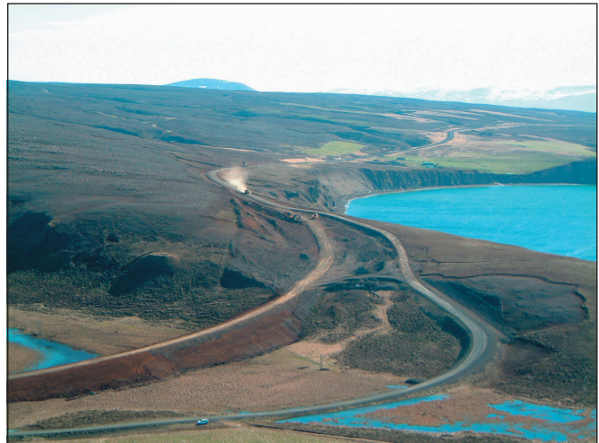
Norðausturvegur (85) á norðanverðu Tjörnési. Kaflinn: Breiðavík - Bangastaðir. Nýr vegur 11,7 km. Verktaki: Árni Helgason, Ólafsfirði. Verklök eru áætluð í september 2004.
