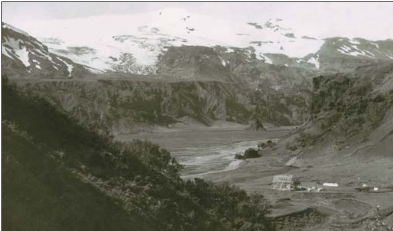
Myndin er tekin í júní 1954 í Þórsmörk. Verið var að byggja sæluhús í Langadal og lauk byggingu sama ár. Það er því 50 ára í ár. Húsið var nefnt Skagfjörðsskáli eftir Kristjáni Skagfjörð, framkvæmdastjóra FÍ, en byggt hefur verið við það síðan. Úr safni Jóns Víðis.
