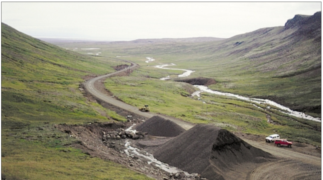
Vatnaleið. Framkvæmdir í ágúst 2001. Verktaki Suðurverk hf.
