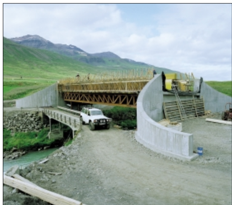
Brúargerð við Hreiðarsstaði í Svarfaðardal 10. ágúst 2002. Ljósmynd Mats Wibe Lund
