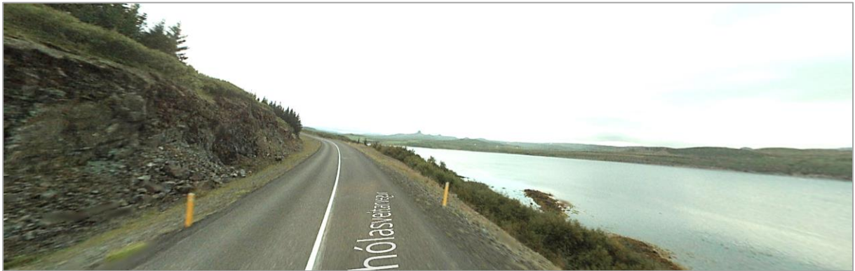
Mynd 6. Horft eftir Reykhólasveitarvegi inn Berufjörð og Barmahlíð.
