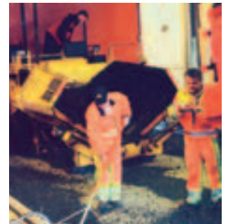
■ Vegagerðarmenn leggja sýnishorn af íslenskum vegi í vegrannsóknastofnun Svíþjóðar en þar fór fram umfangsmikil álagsprófun á íslensku efni til vegagerðar.
