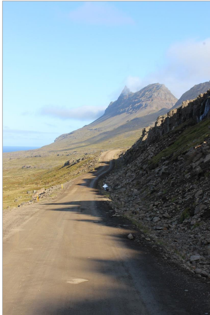
Mynd 0. Núverandi vegur undir Langahjalla (Ljósmynd: Helga Aðalgeirsdóttir, 2019).
