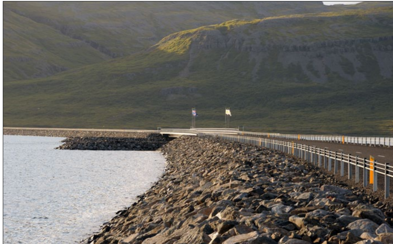
Vestfjarðavegur (60) yfir Kjálkafjörð.
