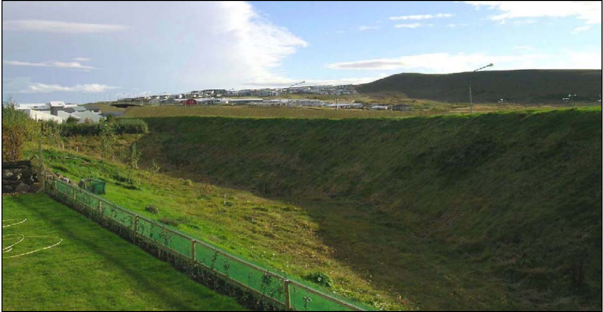
Mynd 5.28 Mynd tekin við Vallarbarð 19-21 og sýnir kost 2 , það er núverandi hljóðmön og gabíon hljóðmanir meðfram Reykjanesbraut með óbreyttri hæðarlegu (ljósmynd: VGK-Hönnun hf., 2006).
