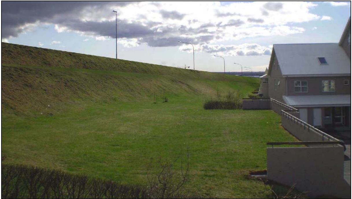
Mynd 5.12 Mynd tekin við Fagrahvamm 4 og sýnir kost 2 , það er 4 m háa gabíon hljóðmön og Reykjanesbraut með óbreytta hæðarlegu (ljósmynd: VGK-Hönnun hf., 2007).
