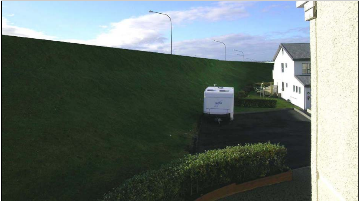
Mynd 5.16 Mynd tekin við Suðurhvam 25 og sýnir kost 2 , það er um 4 m háa gabíon hljóðmön. Ekki er mögulegt að lækka Reykjanesbraut á þessum stað (ljósmynd: VGK-Hönnun hf., 2006).
