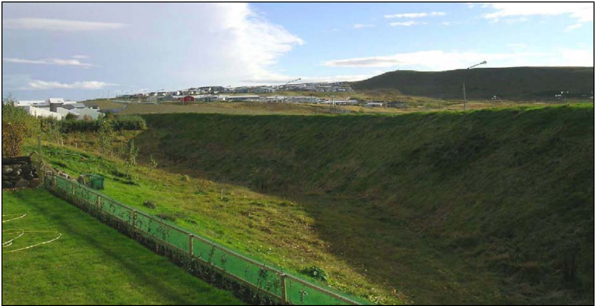
Mynd 5.29 Mynd tekin við Vallarbarð 19-21 og sýnir kost 1 , það er núverandi hljóðmön og gabíon hljóðmanir meðfram lækkaðri Reykjanesbraut fjær (ljósmynd: VGK-Hönnun hf., 2006).
