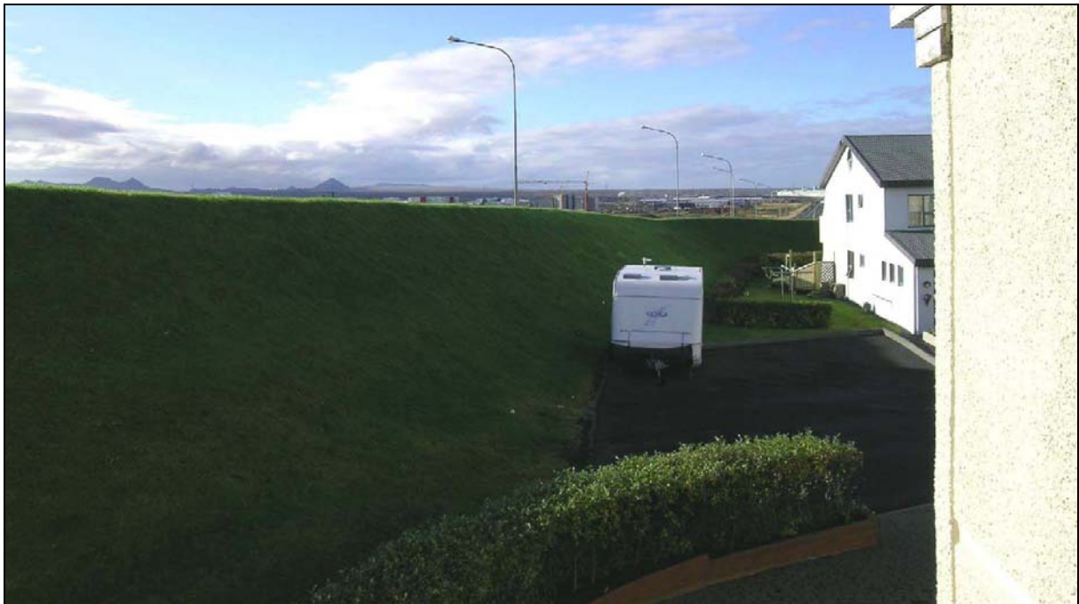
Mynd 5.15 Mynd tekin við Suðurhvamm 25, og sýnir núverandi hljóðmön um 2 m háa yfir vegi, meðfram Reykjanesbraut (ljósmynd: VGK-Hönnun hf., 2006).
