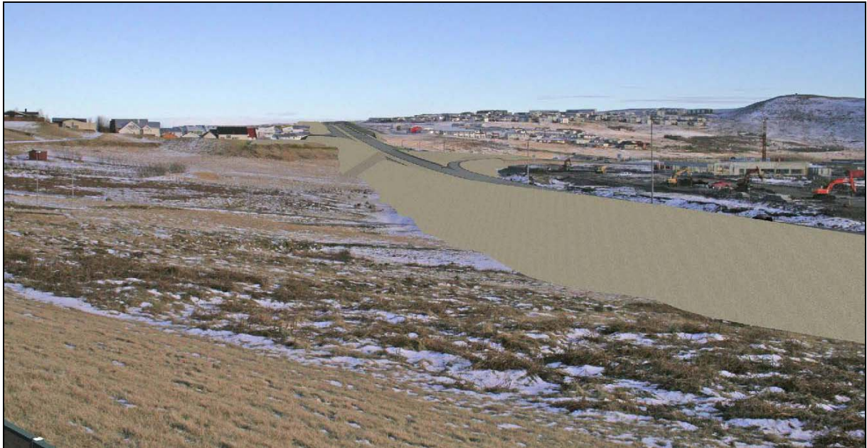
Mynd 5.32 Mynd tekin austan við Hvaleyrarskóla og sýnir kost 2 , það er misháar hljóðmanir meðfram Reykjanesbraut með fjórar akreinar og óbreytta hæðarlegu (ljósmynd: VGK-Hönnun hf., 2007).
