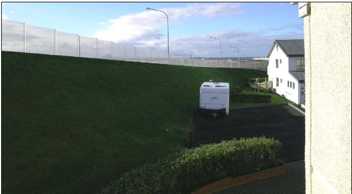
Mynd 5.17 Mynd tekin við Suðurhvam 25 og sýnir kost 1 , það er 2 m háan hljóðvegg úr gleri ofan á nýrri 2 m gabíon hljóðmön. Ekki er mögulegt að lækka Reykjanesbrautina á þessum stað (ljósmynd: VGK-Hönnun hf., 2006).
