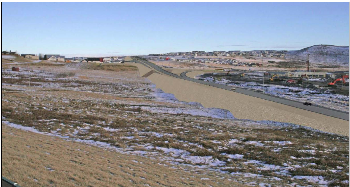
Mynd 5.33 Mynd tekin austan við Hvaleyrarskóla og sýnir kost 1 , það er misháar hljóðmanir meðfram lækkaðri Reykjanesbraut með fjórar akreinar (ljósmynd: VGK-Hönnun hf., 2007).
