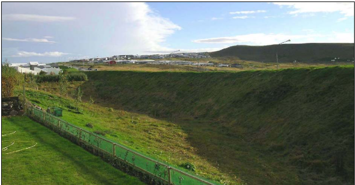
Mynd 5.27 Mynd tekin við Vallarbarð 19-21 og sýnir núverandi hljóðmön meðfram Reykjanesbraut (ljósmynd: VGK-Hönnun hf., 2006).
