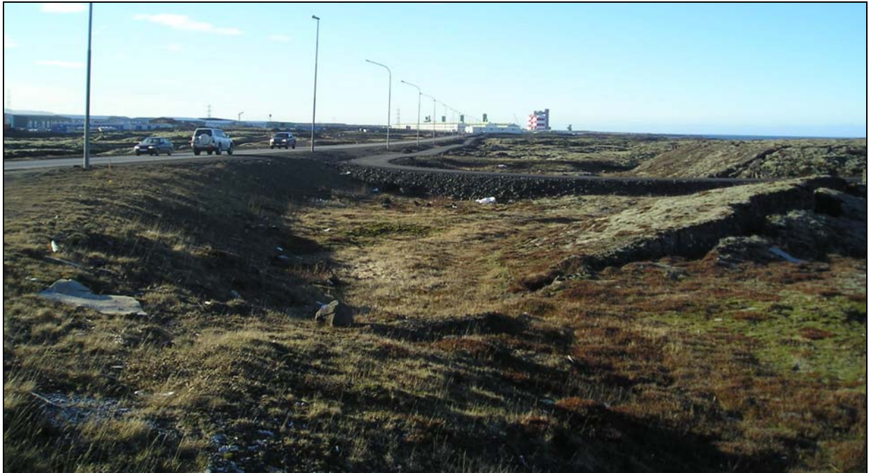
Mynd 5.44 Ljósmynd tekin norðan Reykjanesbrautar í vesturátt. Eftir því sem vestar er farið verður lítt raskað eldhraun meira áberandi. Á myndinni sést göngustígur sem sveigir í átt að Reykjanesbraut og liggur síðan meðfram henni (ljósmynd: VGK-Hönnun hf., 2006).
