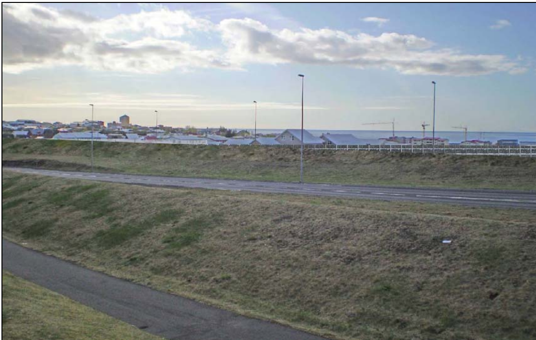
Mynd 5.25 Mynd tekin við Blikaás 13 og sýnir kost 1 , það er um 2 m háa hefðbundna hljóðmön við lækkaða Reykjanesbraut (ljósmynd: VGK-Hönnun hf., 2007).
