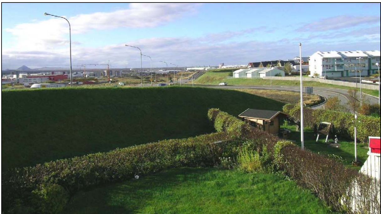
Mynd 5.19 Mynd tekin við Suðurhvamm 22 og sýnir núverandi hljóðmön meðfram Reykjanesbraut og rampa að Strandgötu (ljósmynd: VGK-Hönnun hf., 2006).
