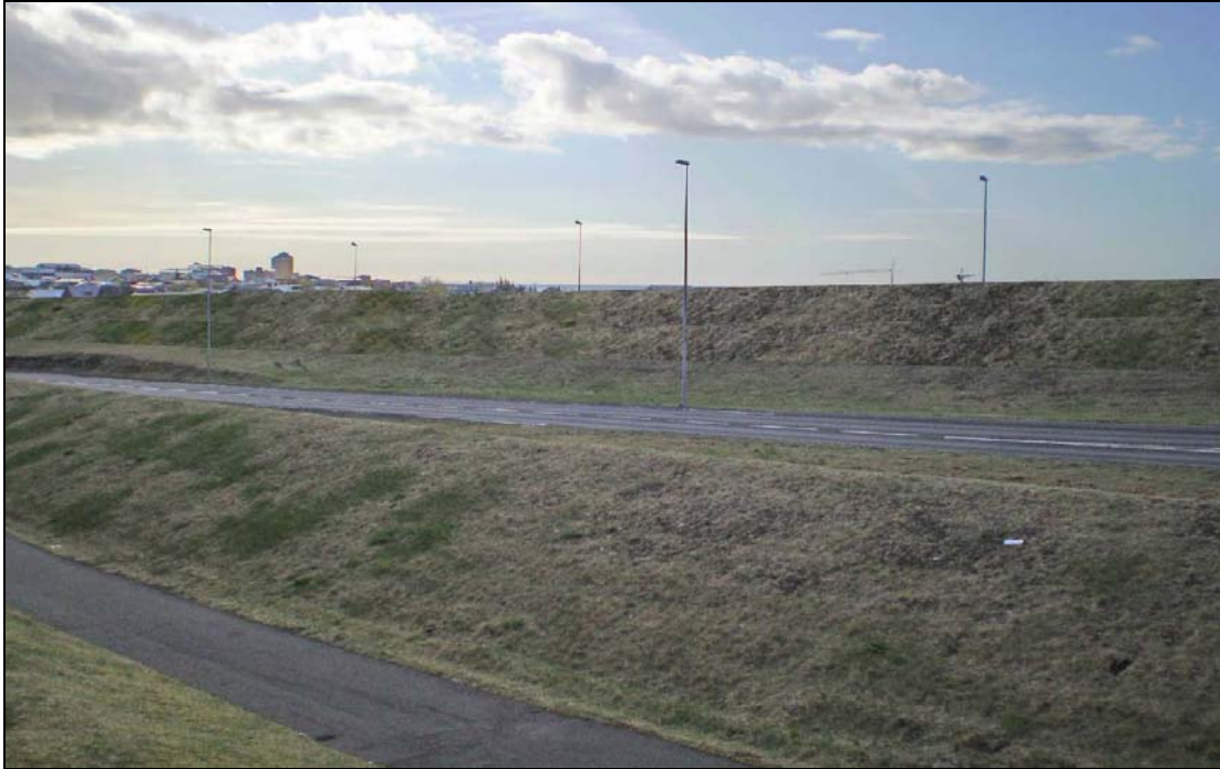
Mynd 5.24 Mynd tekin við Blikaás 13 og sýnir kost 2 , það er 4 m háa hefðbundna hljóðmön við Reykjanesbraut með óbreytta hæðarlegu (ljósmynd: VGK-Hönnun hf., 2007).
