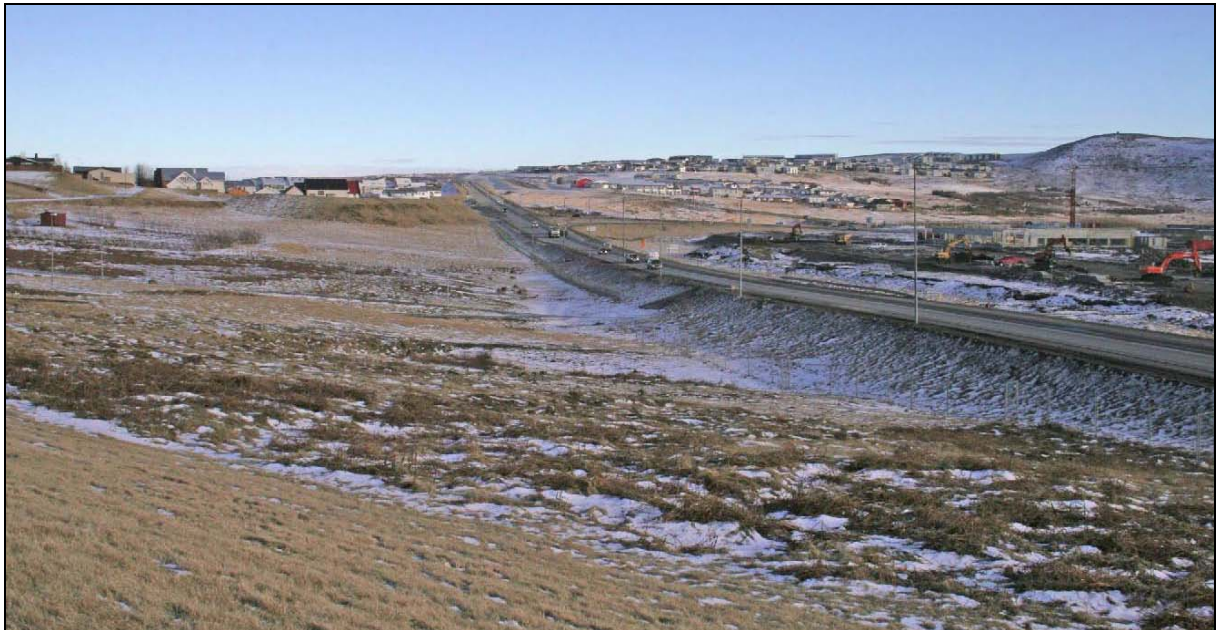
Mynd 5.31 Mynd tekin austan við Hvaleyrarskóla og sýnir núverandi Reykjanesbraut (ljósmynd: VGK-Hönnun hf., 2007).
