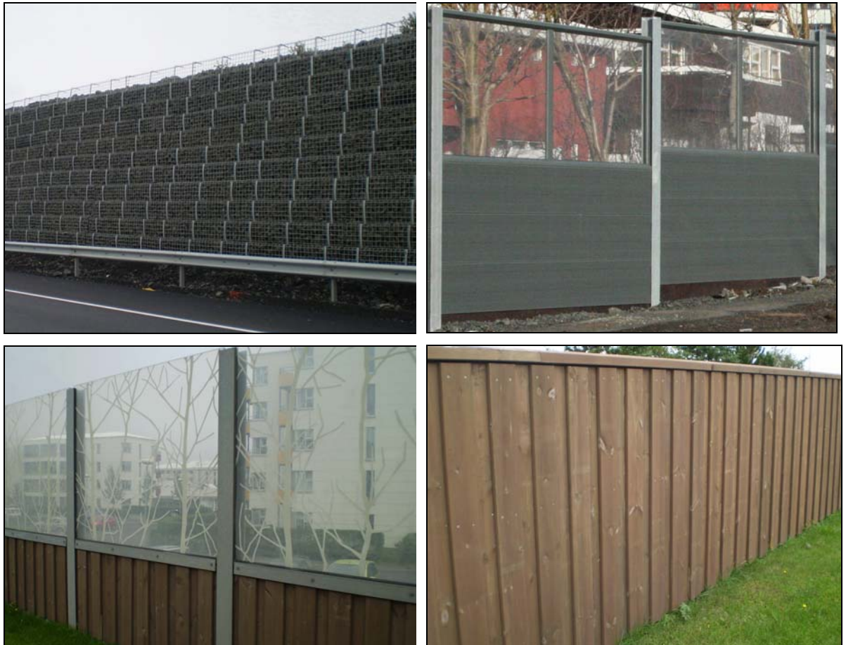
Mynd 5.5 Gabíon hljóðmön (efst til vinstri). Dæmi um útlit hljóðveggja, úr gleri og áli (efst til hægri), úr gleri og timbri (neðst til vinstri), úr timbri (neðst til hægri) (ljósm.: VGK-Hönnun hf., 2007).
