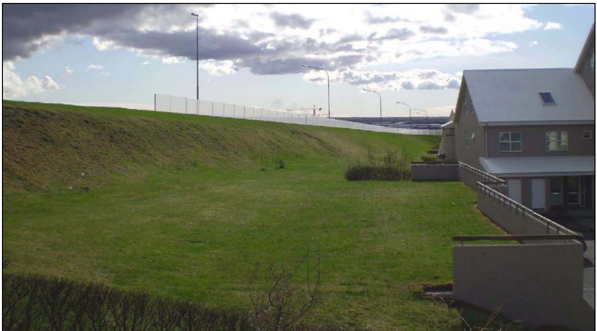
Mynd 5.13 Mynd tekin við Fagrahvamm 4 og sýnir kost 1 , það er 2 m háan hljóðvegg úr gleri ofan á nýrri 2 m gabíon hljóðmön og lækkaða Reykjanesbraut (ljósmynd: VGK-Hönnun hf., 2007).
