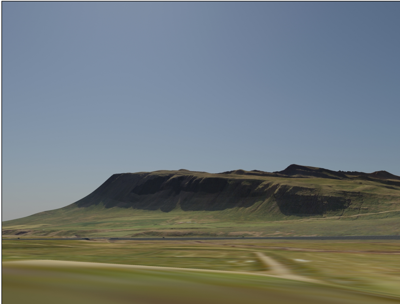
Árið 2013. Strax að loknum framkvæmdum.
