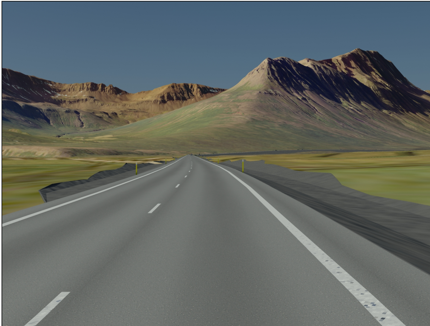
Árið 2013. Strax að loknum framkvæmdum.
