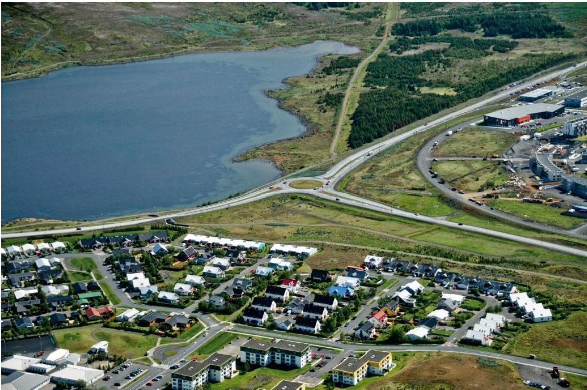
MYND 3.5 Vegamót Suðurlandsvegur og Breiðholtsbrautar.
