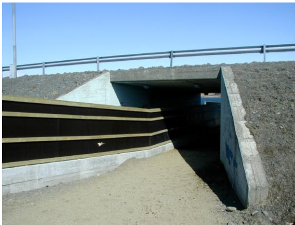
MYND 2.19 Undirgöng við Rauðavatn.
