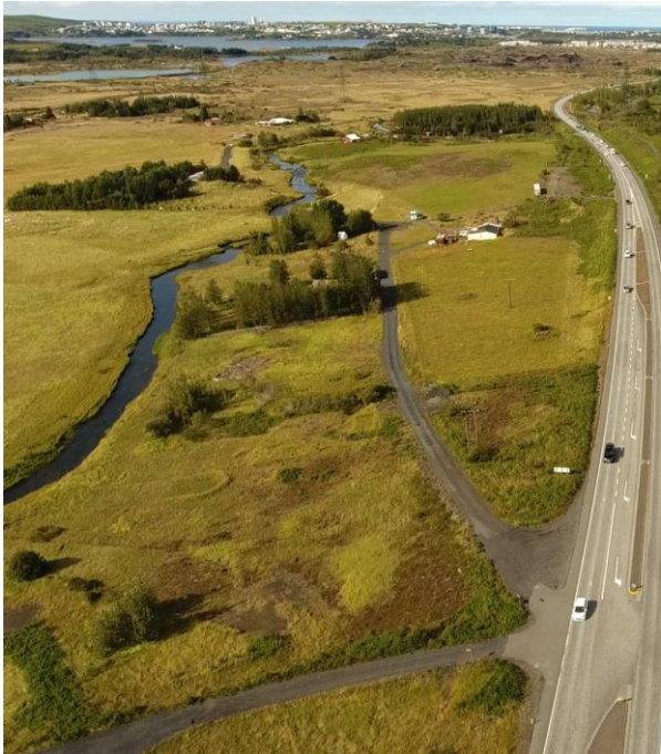
MYND 5.37 Séð til vesturs frá vegamótum við Hafra- vatnsveg. Hér liggur áin í góðri fjarlægð frá veginum (mynd EFLA).
