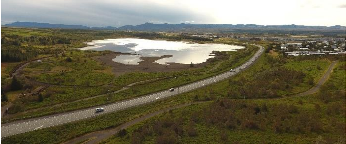
MYND 2.7 Suðurlandsvegur frá Bæjarhálsi.
