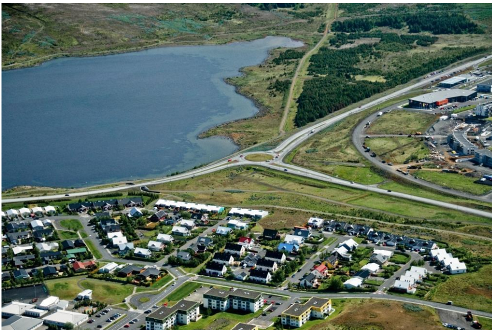
MYND 2.2 Sunnanvert Rauðavatn. Byggðin þrengir að vegstæðinu.
