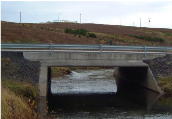
MYND 2.16 Brú yfir Bugðu í st. 5.580).
