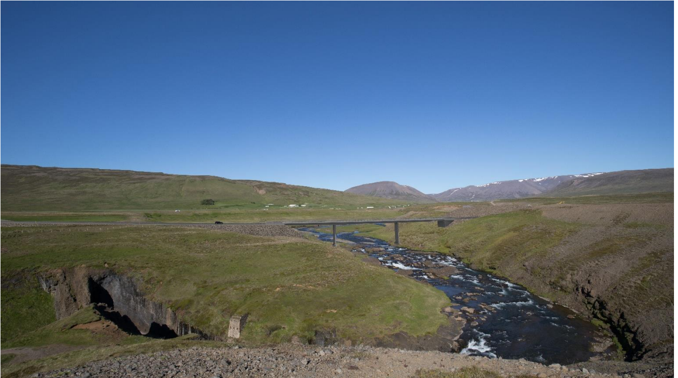
Mynd 24. Sjónarhorn 1 – Eftir framkvæmd.
