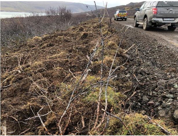
Mynd 1. Vegstöð 5400-5500. Þekjuhluftfall víða yfir 50% og allt upp í 70% sem er mjög æskilegt.
