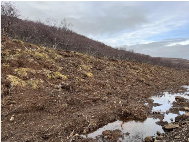
Mynd 2. Vegstöð 6150. Þekjuhluftfall sumstaðar 30-40%, mætti gjarnan vera hærra, en innan marka.
