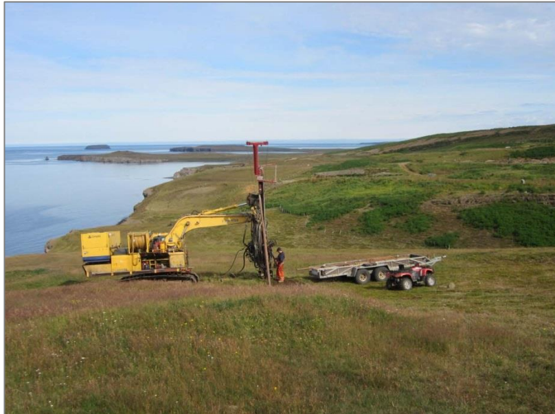
Mynd 13. Borun skáholunnar HH-02 í suðurhlíð Laugardalslæggðarinnar í um 45 m hæð yfir sjó. Horft til norðurs og er munnasvæðið skammt norðan við borinn. Bakkahöfði, Héðinshöfði og Lundey í baksýn (ljósmynd: GeoTek ehf, 2012).
