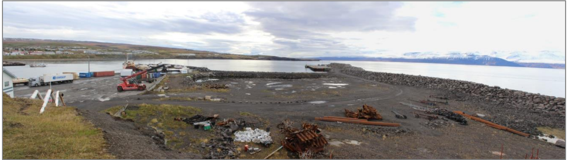
Mynd 29. Landfyllingarsvæðið við Bökugarð (ljósmynd: Helga Aðalgeirsdóttir, 2013, samsetning: Ólafur Hreinsson).
