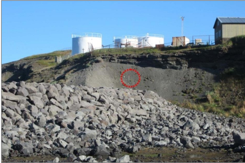
Mynd 11. Munnasvæði við Bökugarð. Hæll í fláa fyrir miðri mynd er miðlína vegar. Forskering verður grafin 180 m inn að gangamunna svo fjarlægja þarf olíutankana. Hálsamlímt siltsteinsvöluberg í bakkanum (ljósmynd: GeoTek ehf, 2012).
