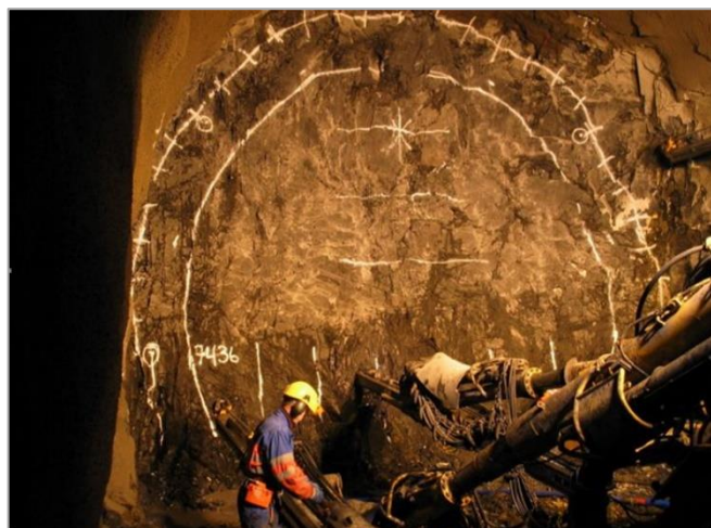
Mynd 4.3.3. Hleðsla og borun í Fáskrúðsfjarðargöngum (mynd: Sigurður Oddsson, 2004)
