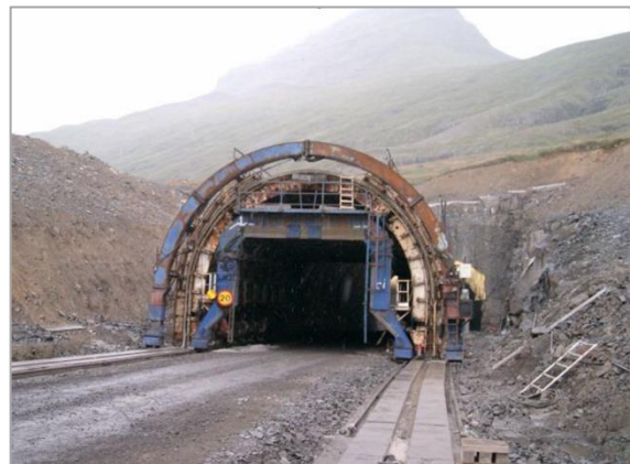
Mynd 4.2.4. Bygging vegskála í Fáskrúðsfjarðargöngum (mynd: Sigurður Oddsson, 2004).
