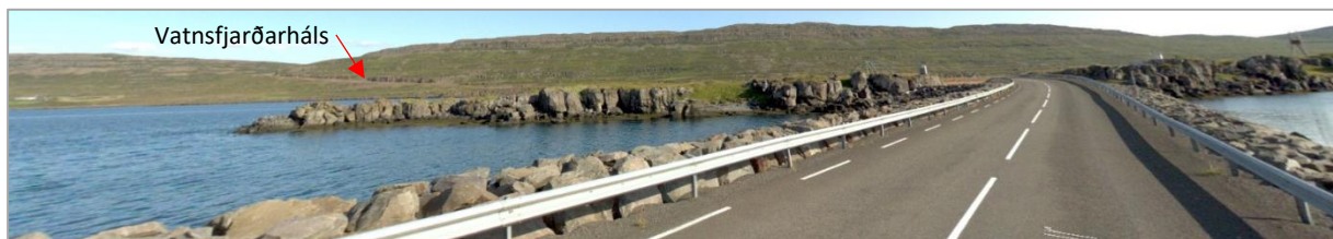
Mynd 3.3.41. Djúpvegur liggur í mjög áberandi sneiðingi upp Vatnsfjarðarháls í Mjóafirði ( www.ja.is ).
