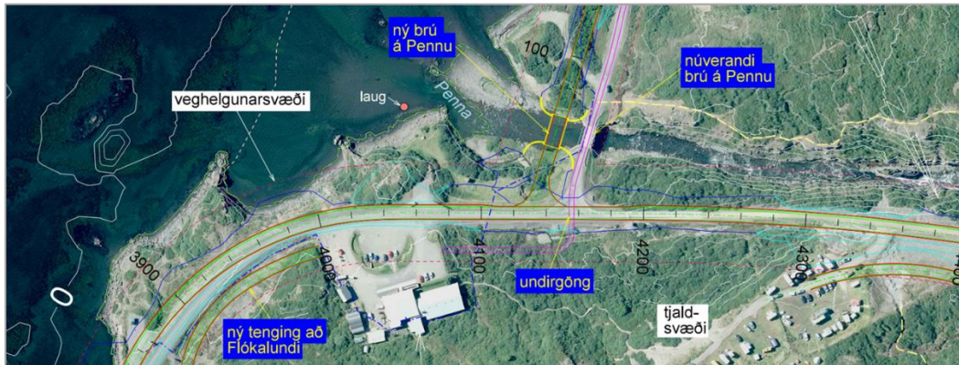
Mynd 3.3.12. Veglína A1 við Hótel Flókalund (loftmynd: Loftmyndir ehf. 2017).
