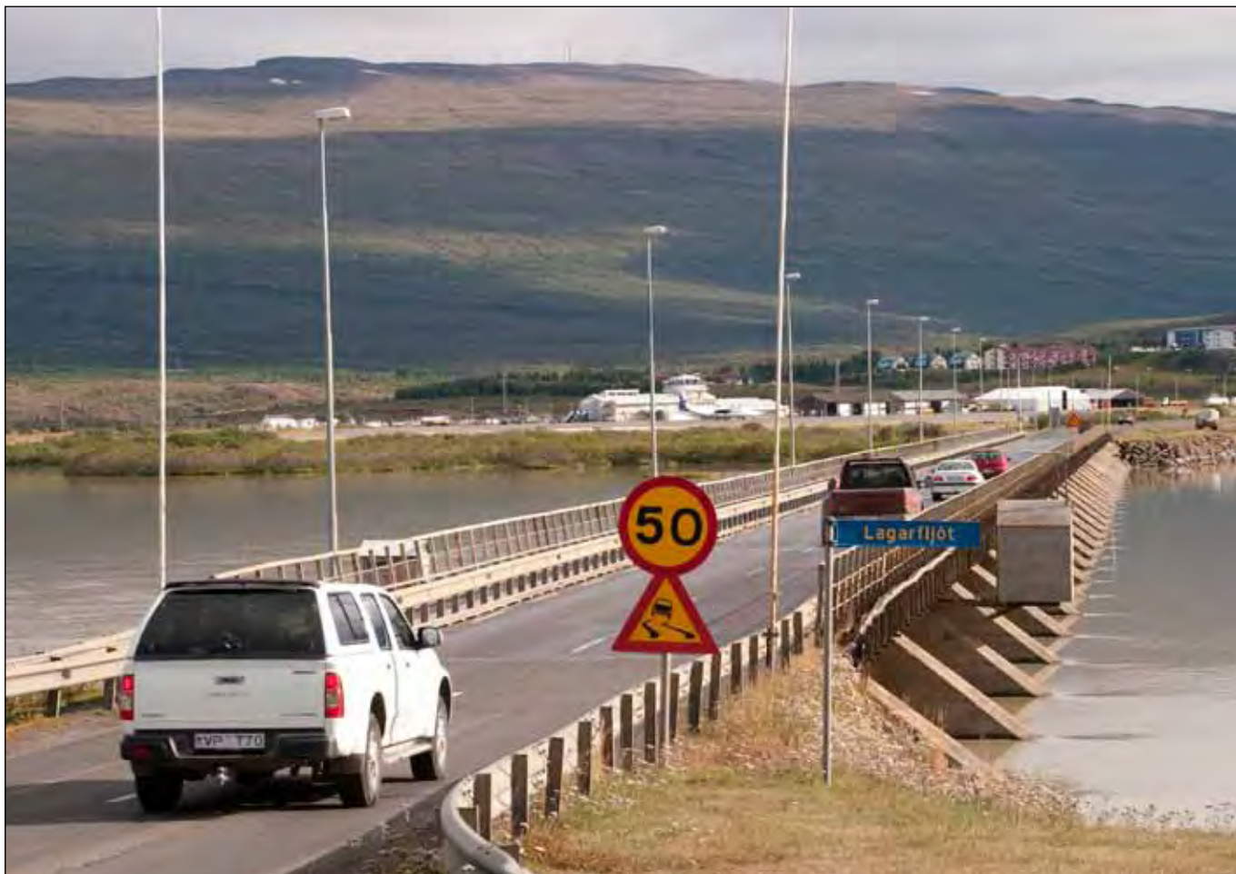
Hringvegur (1) í Fellabæ. Brú yfir Lagarfljót. Egilsstaðir og Egilsstaðaflugvöllur handan fljótsins.
