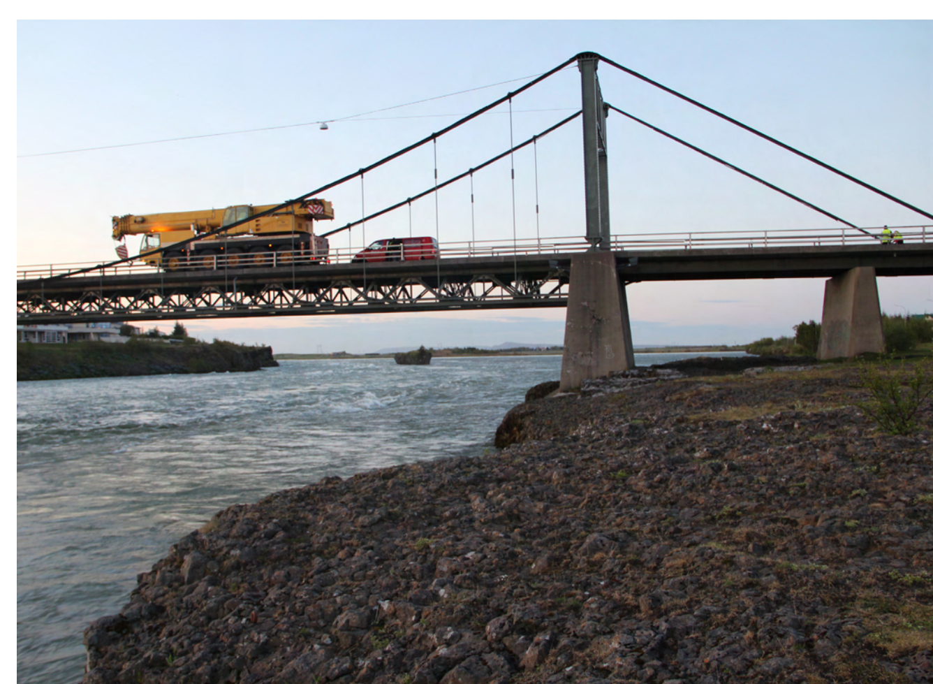
Titringsmælingar brúargólfs / álagspróf með 60 tonna bílkrana
